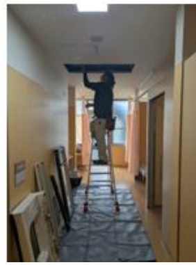
天井埋込型空調機解体洗浄
