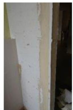
壁クロス剥がれ補修
